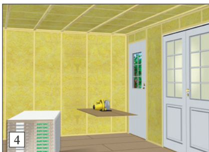
4) Første plate i første platerad tilskjæres iflg. tidligere tegning, og ved skjæring med sirkelsag skal den malte siden vende ned.
