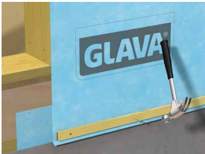
Fig. 36 Klemming av vindsperre mot grunnmursvill
