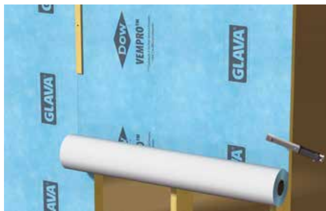
Fig. 35 Vertikal montering av vindsperre
