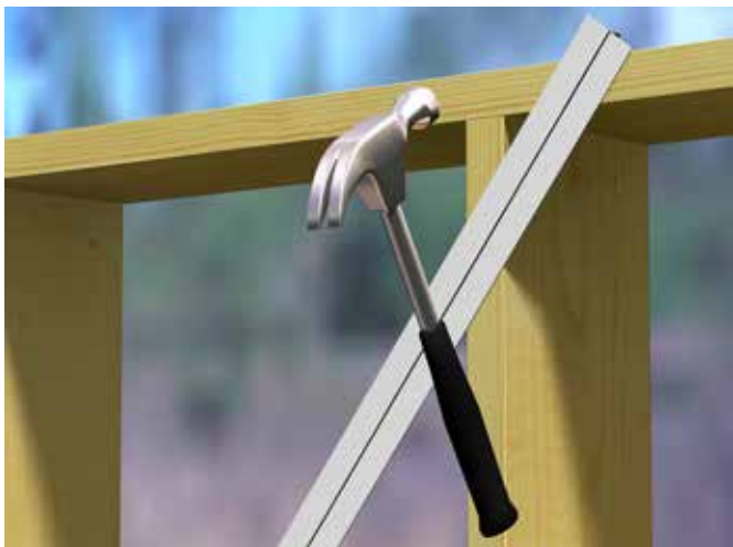
Fig. 31 Avstivningsstag bankes inn i slissen
