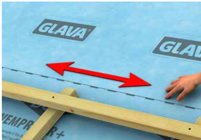
Fig. 9 Utstryking av omlegg
