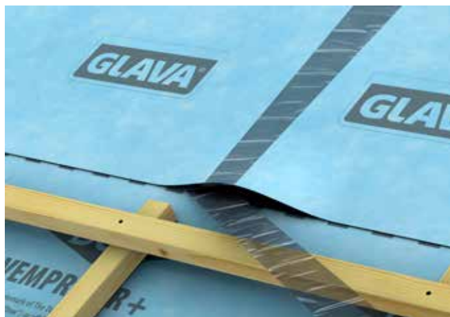
Fig. 8 Fjerning av dekkfolie på klebekanter
