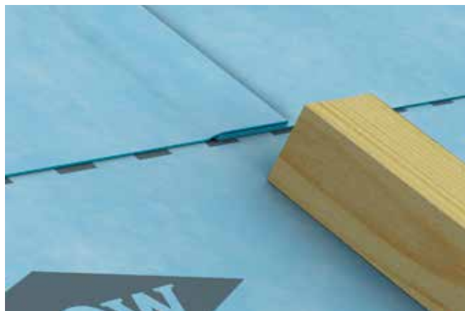
Fig. 13 Innbretting av duk ved skjøt
