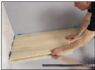
Den næste række startes igen fra venstre. Klik blot plankerne sammen på langsiden. Det er ikke nødvendigt at lime plankerne.
