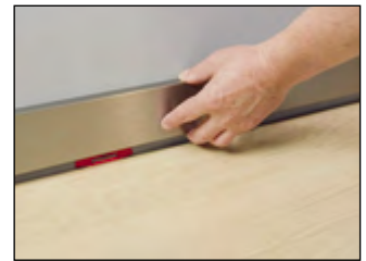
Tildæk kantfuger med passende fodlister fra det omfangsrige Parador sortiment.
