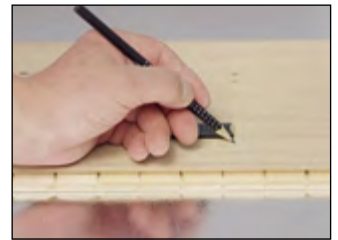
Den sidste plank i første række afkortes til den nødvendige længde i forhold til vægafstanden. Det afskårne stykke af planken anvendes som første stykke i række nr. 2.
