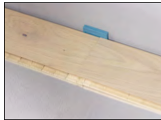
Hold en afstand på mindst 10 til 15 mm fra alle vægge og faste genstande i rummet ved hjælp af afstandskilerne.
