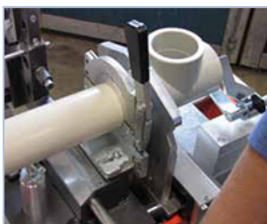
Lim sammen rør og muff.
