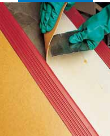
Installasjon av PVC på et trappetrinn
