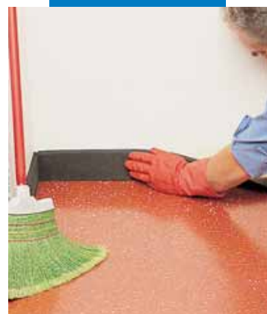
Liming av gulvlister i PVC
