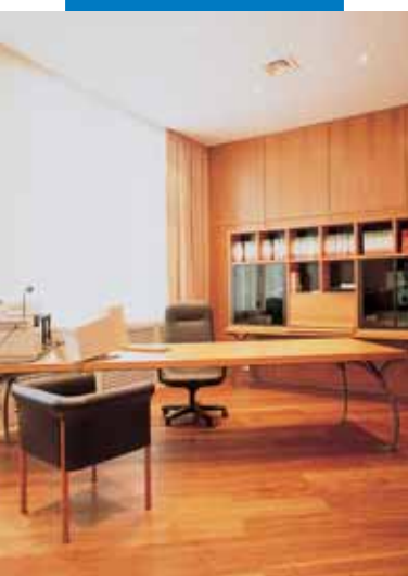
Expo Sevilla (Spania) - Palazzo Italia: Wudawood - Luini gulvbelegg installert med Adesilex VZ
