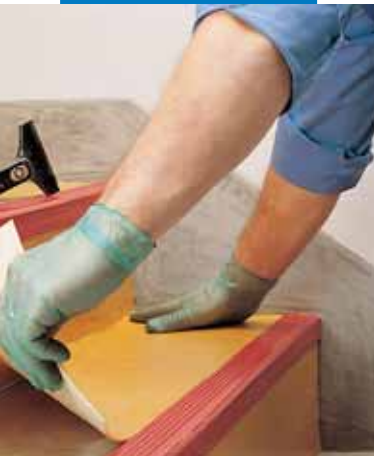
Påføring av Adesilex VZ på baksiden av et belegg
