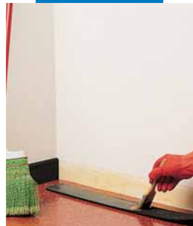
Påføring av Adesilex VZ på baksiden av en gulvlist
