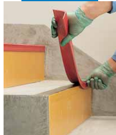
Installasjon av en trappnese i PVC
