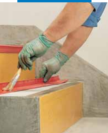
Påføring av Adesilex VZ på baksiden av en trappenese
