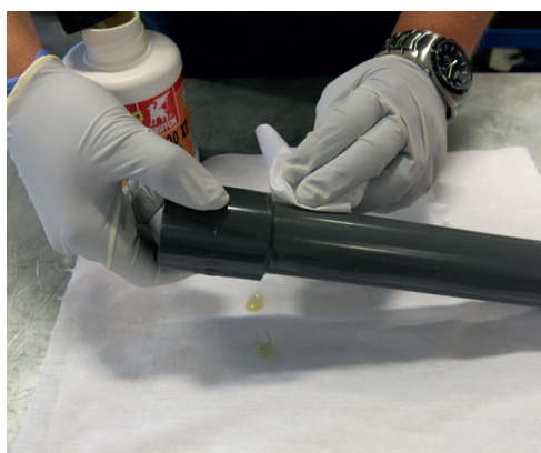
Tørk av overflødig lim.
