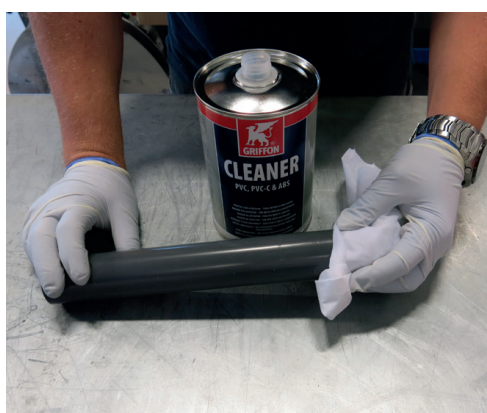
Rengjør rør og rørdel.
