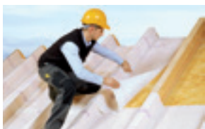
Montering av dampbrems ved takreovering fra utsiden
