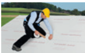
Montering av dampbrems ved isolering fra utsiden
