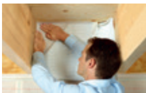
Lufttetting mellom bjelkelag
