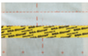
Overlappinger av dampbrems
