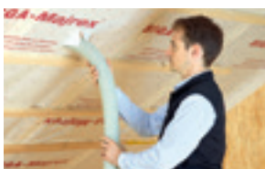
Montering av dampbrems ved blåseisolasjon
