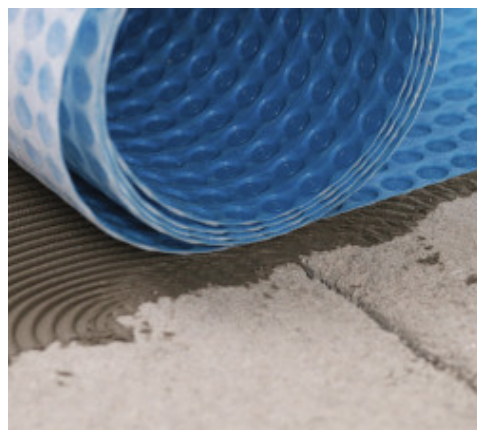
Legging av Mapeguard UM 35
