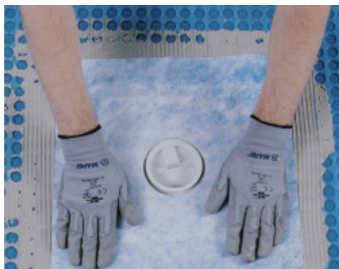
Vanntetting av avløp med Mapeband Easy quadrotto 200x200 eller 400x400 mm
