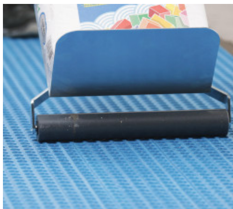
Fastpressing av Mapeguard UM 35
