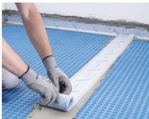
Tetting av skjøter mellom stykker med Mapeband Easy, limt med Mapeguard WP Adhesive
