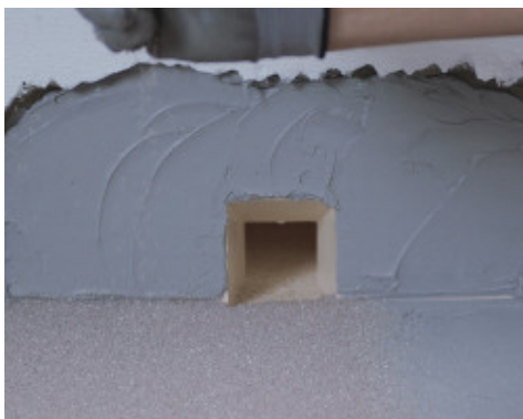
Tetting langs kantene med Mapeband Easy, limt med Mapeguard WP Adhesive
