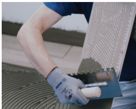
Monter keramikk- eller steinflisene med et egnet Mapei-lim minst av klasse C2
