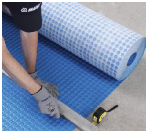
Tilskjæring av Mapeguard UM 35
