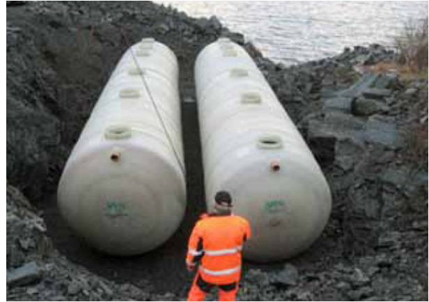
Slamavskiller med direkte utslipp til sjø.
