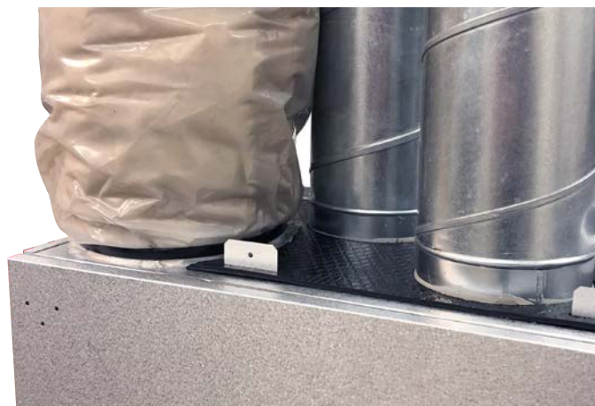
Figur 11 Ferdig monterte kanaler
