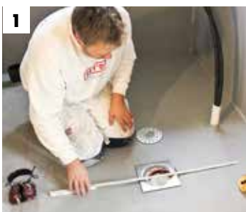
Planlegg og mål til alle rør og sluk
