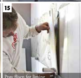
Prøv flisen for liming
