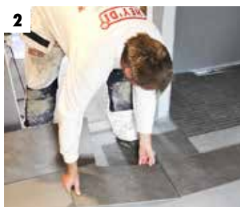
Prøvelegg flisene før liming
