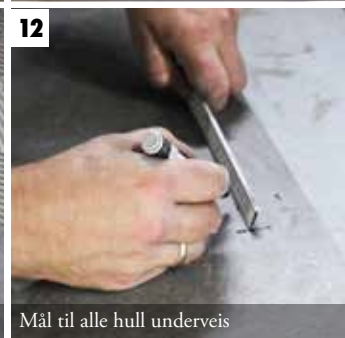
Tilpass flisene til sluket
