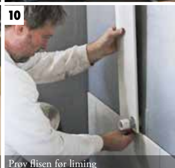
Prøv flisen for liming
