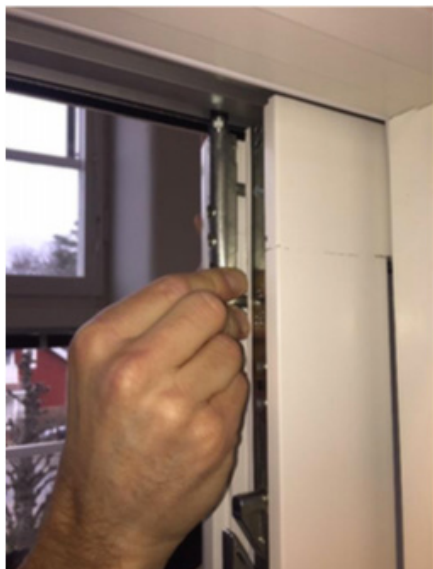
5. Ved tilbakesetting av skyvefeltet; følg 4-1 og sørg for at hjulene er på linje før påmontering. Bilde under viser korrekt posisjon.
