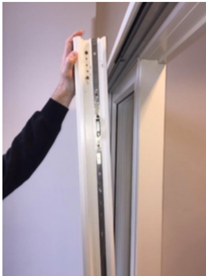
5. Ved tilbakesetting av skyvefeltet; følg 4-1 og sørg for at hjulene er på linje før påmontering. Bilde under viser korrekt posisjon.
