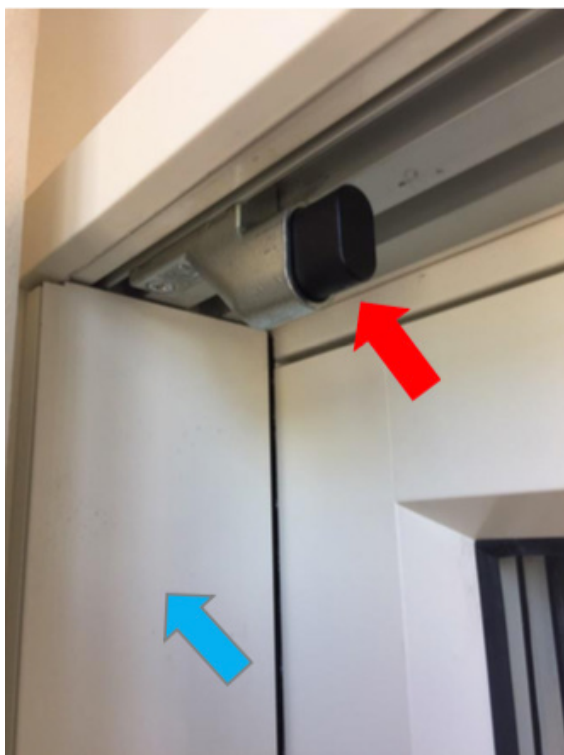
Fig. 2: På sidene erstattes tradisjonell klossing med justerbare karmhylser som er skrudd fast i karmen fra utsiden og justeres fra innsiden med en umbrako-nøkkel
