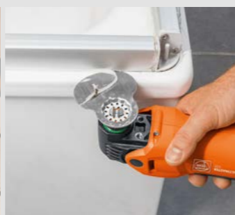
Elastisk tetningsmasse løses perfekt før ny fugging.
