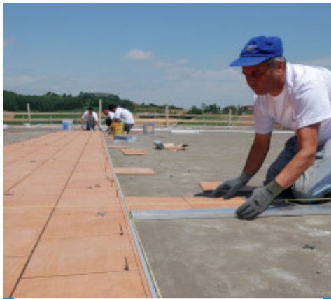
Flislegging med Kerabond + Isolastic
