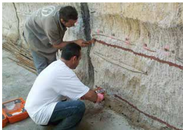
Tilslutning mellom slissevegger
