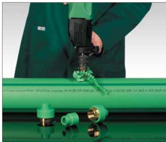
Gjennom boring av rørvæggen
