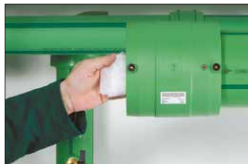
Rengjør el-sveisemuffen på nytt
