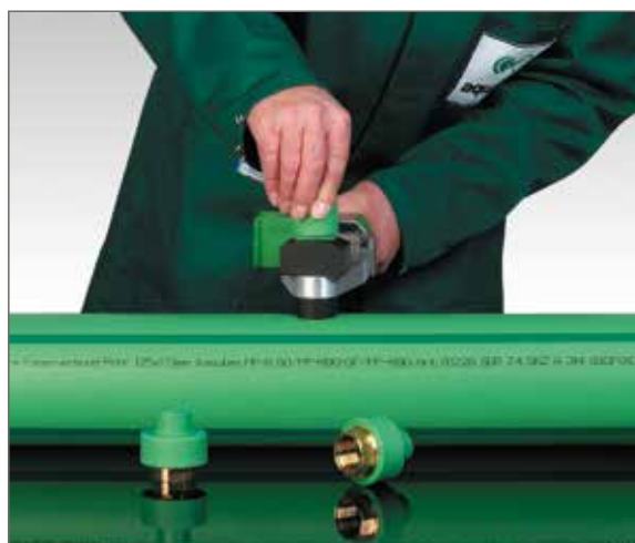
Oppvarming av rør og rørdel
