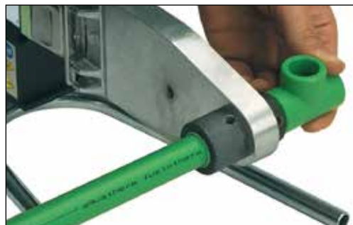
Oppvarming av rør og rørdel
