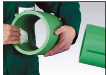
Rengjør el-sveisemuffens innside
