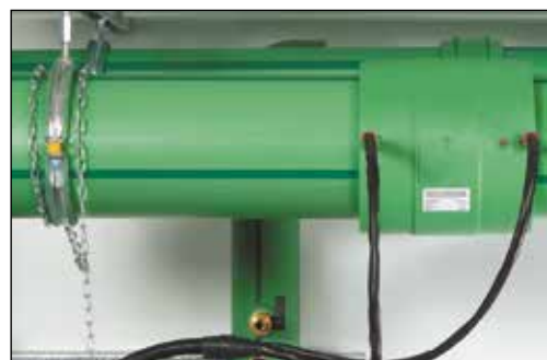
Still sveisemaskinen på riktig dimensjon. Start sveisingen og overvåk hele prosessen. Overhold avkjølingstiden.
