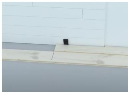
**Skjøting:** Gulvbordene kan limes i endeskjøtene og presses på plass med kiler. Bruk gjerne spesialredskap for å slå bordene godt på plass så skjøten blir tett. Overflødig lim tørkes bort straks med en fuktig klut. Obs! Langsidene skal ikke limes når gulvet skal skrues. Unngå at to rader gulvbord ved siden av hverandre skjøtes samme sted!
