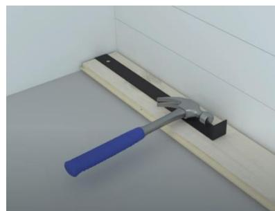
Skru fast den første raden av gulvbord . Pass på at skruhodene dekkes av list som skal legges senere (gulvbordets not-side). Sett så i skruer med 45 graders vinkel i overkant av fjæren (gulvbordets fjær-side). Avstanden mellom skruene skal være ca. 60 cm, en ved hver bjelke.
