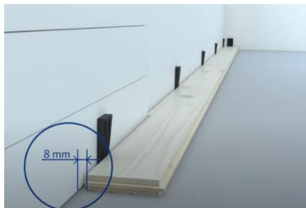
Tilpasning av lengder: Bordet som skal kappes ved vegg legges løst på plass i motsatt retning av hvordan det skal monteres. Merk med blyant for kapping, og sag av. Monter så bordet på plass. Husk å bruke avstandsklosser.
