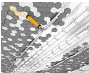
Liming av tak for lyddemping
