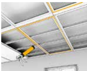
Liming av plater til trerammer
