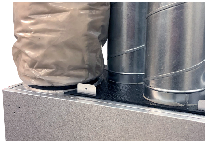
Figur 11 Ferdig monterte kanaler
