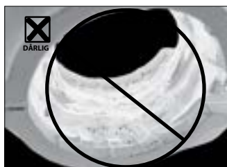
Feil smurt Installation-Ready pakning med for mye smøremiddel
