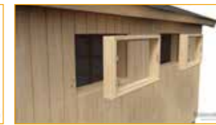
Monter vinduer og dører
