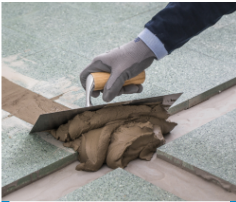
Fylling av utsparing med Planipatch Xtra Zero
