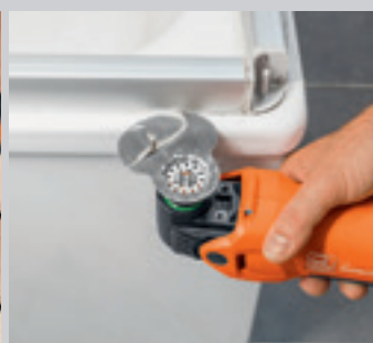
Elastisk tetningsmasse løses perfekt før ny fugging.
