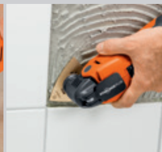
Hardmetallraspen jevner ut fliselimet og sørger for et plant underlag.
