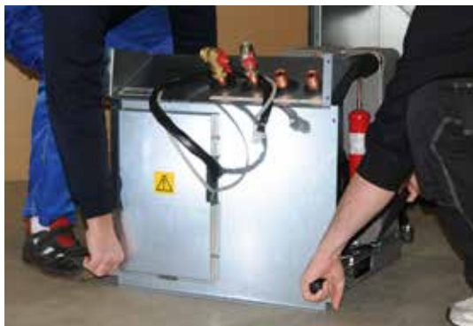
5. Løft kjølemodulen ved hjelp av bærehåndtakene og bæreremmene.
