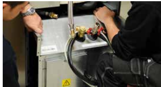
4. Dra ut kjølemodulen ved først å løfte fremkanten litt opp i bærehåndtakene.
