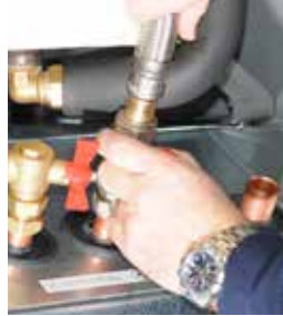
1. Løsne kjølemodulens strømkontakt og slanger.
