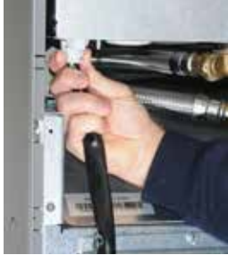
1. Løsne kjølemodulens strømkontakt og slanger.
