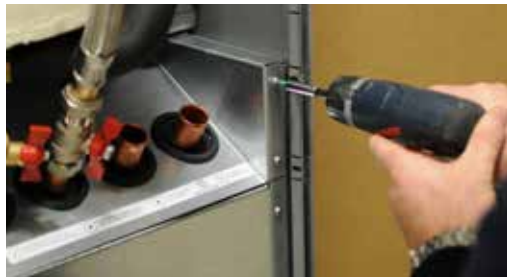
3. Skru ut kjølemodulens festeskruer.
