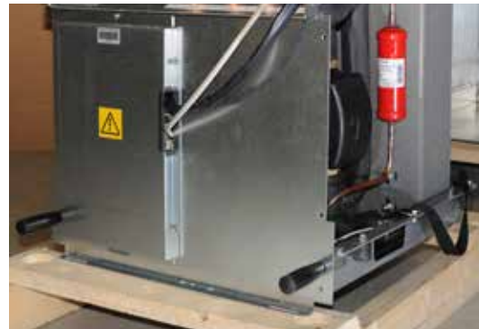
6. Løfte kjølemodulen inn i produktet ved hjelp av bærehåndtakene og bæreremmene. Løsne bærehåndtaket, og monter strømkontaktene, slangene og skruene igjen.
