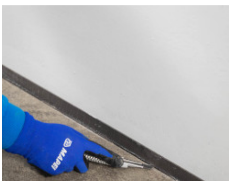
Når fugemassen har herdet, klippes ytterkanten med Mapesonic Strip for å fjerne overfløydig materiale
