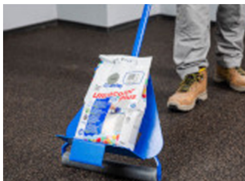
Vals eller gni over hele overflaten med en hard rulle eller et flat sparkel. Begynn på midten og jobb ut mot kantene
