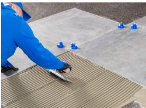
Etter egnet klargjøring av underlaget, spres limet for å feste de lydisolerende mattene
