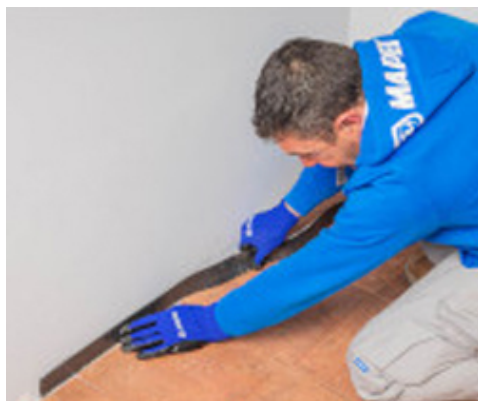
Legg Mapesonic Strip selvklebende tape langs ytterkanten av rommet
