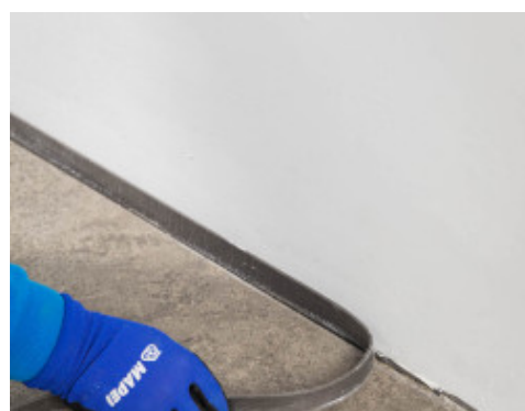
Fordele limet på Mapesonic CR og monter det nye belegget/fliser
