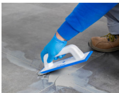
Vals eller gni over hele overflaten med en hard rulle eller et flat sparkel. Begynn på midten og jobb ut mot kantene
