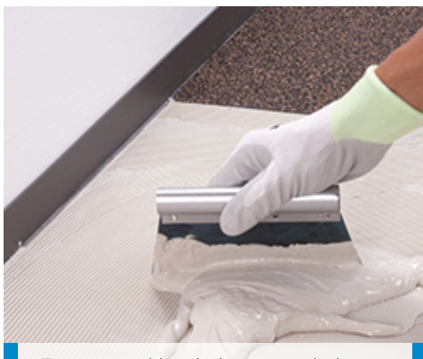
Etter egnet klargjøring av underlaget, spres limet for å feste de lydisolerende mattene
