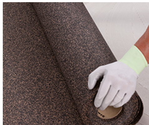
Rull ut mattene med Mapesonic CR på underlaget som skal lydisoleres
