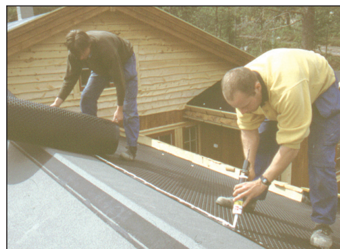
Fugemasse som sikring i omlegg.
