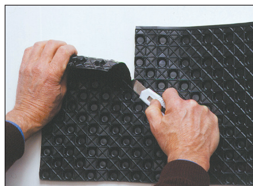
Rillene virker som skjæreanvisning.
