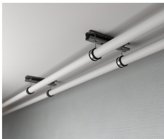
Eksempel på fiksering ved horisontal forlegning.
