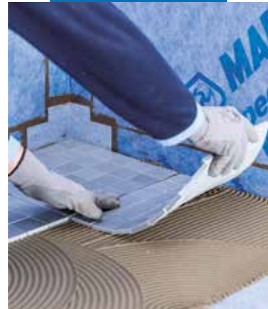
Legging av fliser
