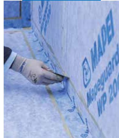
Påføring av Mapeguard ST
