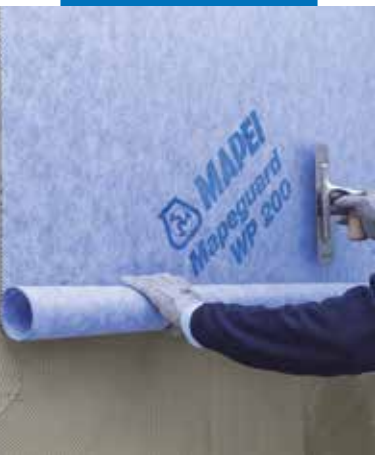
Montering av Mapeguard WP 200
