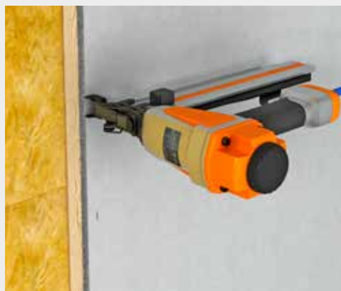
Powerpanel H 2 O plader skydes eller skrues fast afhængig af underkonstruktionen.
