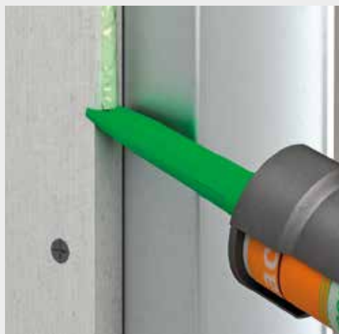
Påfør fermacell Fugeklæber midt på pladens kant
