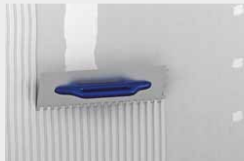
figur 1: Påføring af fermacell Letmørtel med 12 mm tandspartel.
