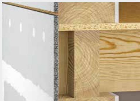
figur 1: Pladestrimmel med korrekt påført armeringsbånd og -klæber.
