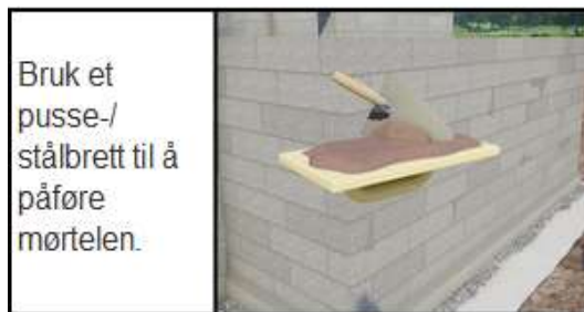
FIGUR 15: BLANDING OG PÅFØRING AV PUSS
