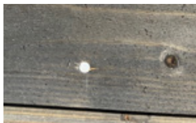
FIG. Spiker- eller skruhode bør ligge i flukt med treoverflaten, som vist til høyre. Foto: Holzforschung Austria
