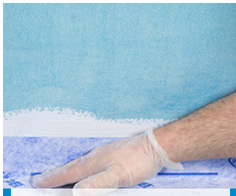
Installering Mapei ST tettebånd ved hjelp av Mapegum WPS, overgang gulv/vegg
