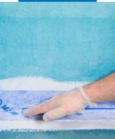
Installering Mapei ST tettebånd ved hjelp av Mapegum WPS, overgang gulv/vegg
