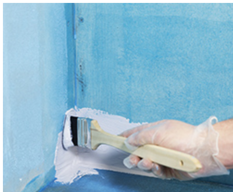
Installering av Mapei IC/EC hjørne mansjett ved hjelp av Mapegum WPS
