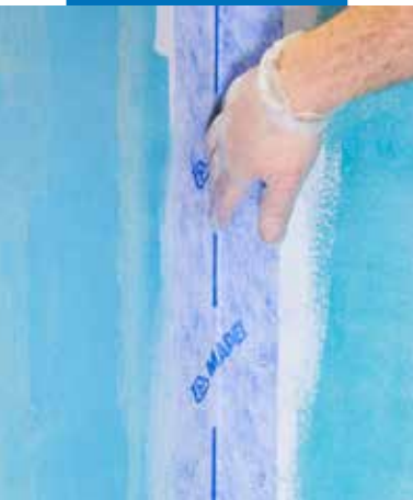
Installering Mapei ST tettebånd ved hjelp av Mapegum WPS, vegg
