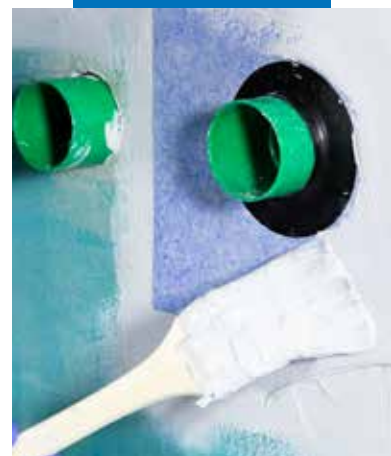
Mapei Rørmansjett montert i Mapegum WPS
