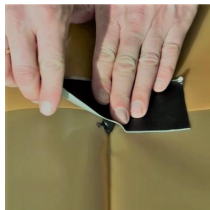
Glava Radontape og Glava Radonfugemasse
