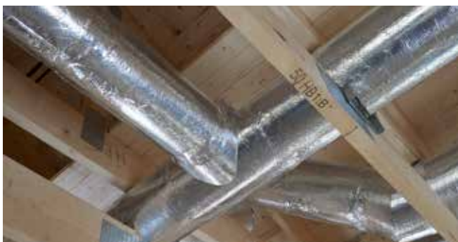
PAROC Hvac AirCoat, installasjon i villa.
