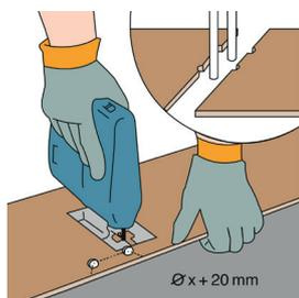
Vid rörgenomföringar, mät upp den exakta placeringen för dessa och markera på plankan. Lägg till 20 mm till rörets dimension, eftersom laminatet måste kunna röra sig i alla riktningar runt röret.
