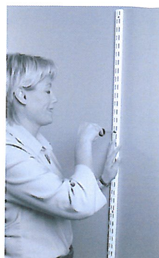
Trinn 3 Bor og skru fast skruene i de resterende hullene.
