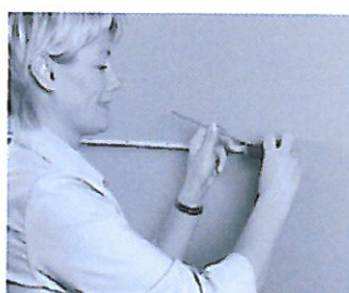
Trinn 5 Gjør klart for neste veggskinne. Mål og merk av c/c avstand, ikke mer enn 900 mm mellom veggskinnene. Hekt en knekt på veggskinnen (som ennå ikke er montert) i samme spor som den første. Pass på at veggskinnene står parallelt slik at knektene kommer i samme høyde.
