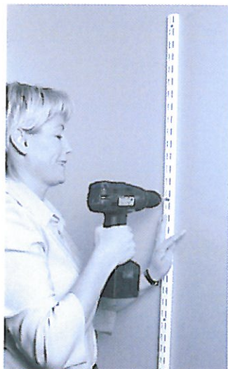
Trinn 1 Montér den første veggskinnen i ønsket høyde på veggen. Begynn med å bore og skru fast i det nest øverste hullet på veggskinnen.
