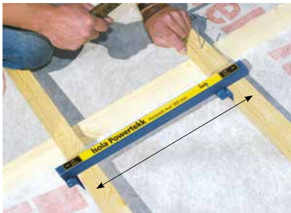
Figur 3.4: Avstandsmåler plasseres fra underkant til underkant av bærelektene
