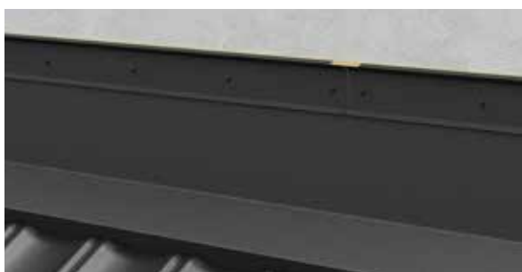
Overgangsbeslag mot mur
