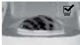
BRA BOLTFFESTE (DEN OVALE HALSEN PÅ HVER BOLT SITTER RIKTIG I BOLTHULLET)
