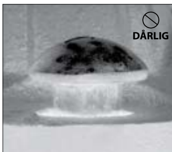
DÅRLIG BOLTFESTE (DEN OVALE HALSEN PÅ HVER BOLT SITTER IKKE RIKTIG I BOLTHULLET)
