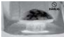
DÅRLIG BOLTFFESTE (DEN OVALE HALSEN PÅ BOLTEN SITTER IKKE RIKTIG I BOLTHULLET)
