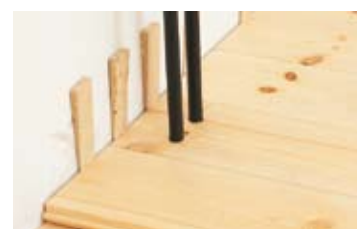
Det lille bakstykket limes fast etterpå
