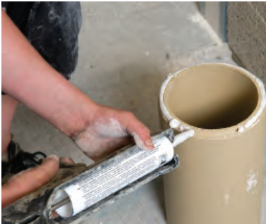
Foringsrøret påføres fugekitt på nedre fals før det monteres. Husk og fjerne over-skytende fugekitt innvendig.
