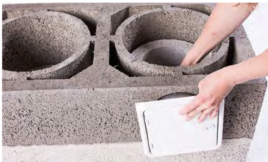
Sotluken monteres og eventuell overskytende pipekleber fjernes.
