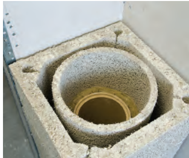
Ytterelement, isolasjon og foringsrør monteres.
