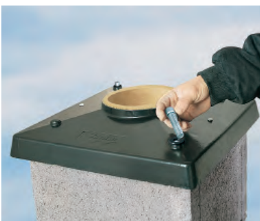
Toppavdekningen monteres med de med-følgende skruene og husk å påføre silikon mellom avdekningen og foringsrøret.
