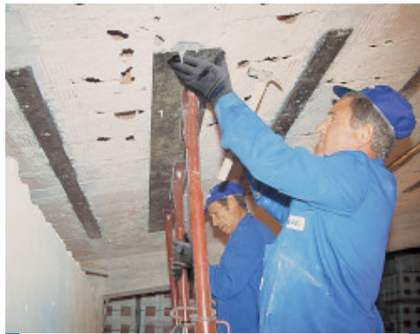
Montering av metallplate for konstruktiv forsterkning
