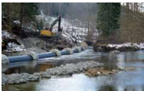
PE-RØR LEGGES I ELV
