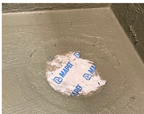
Mapeband B DC montert over sluk og smurt med Mapeguard WP 2K Membrane før klemring monteres
