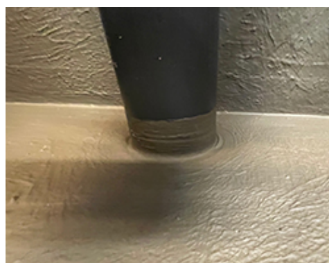
Mapeguard PC mansjett smurt over mansjetten med Mapeguard WP 2K Membrane
