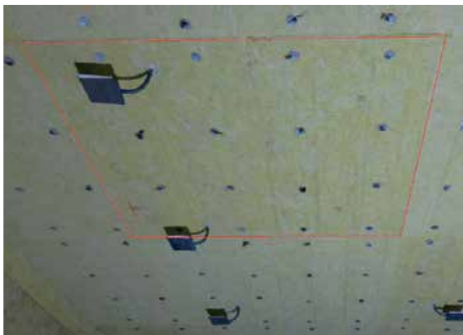
Viser ferdig brannbeskyttelse av trapesformet metallplater med isolasjon, dimensjon 1000x1200mm Isover FireProtect 150 plate markert med rød linje.
