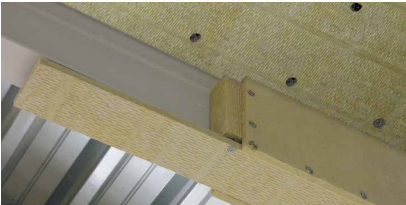
Viser ferdig brannbeskyttelse av trapesformet metallplater med isolasjon, dimensjon 1000x1200mm Isover FireProtect 150 plate markert med rød linje.
