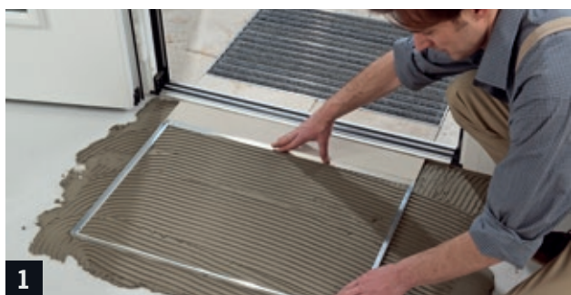
1 Plasser og trykk kantrammen i aluminium ned i det påførte flislimet.
