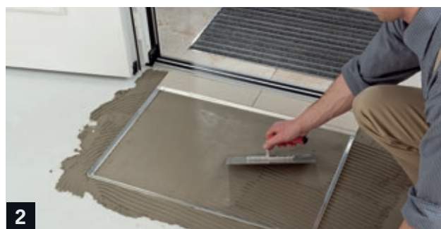
2 For å få en pen overflate avrettes flislimet inne i rammen, og fjern overflødig lim.
