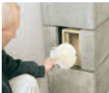
Monter sotfanger. Bena kan justeres ut/inn for nøyaktig tilpasning.
