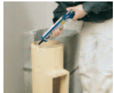
Påfør fugekitt på sotluckerørets nedre fals.
