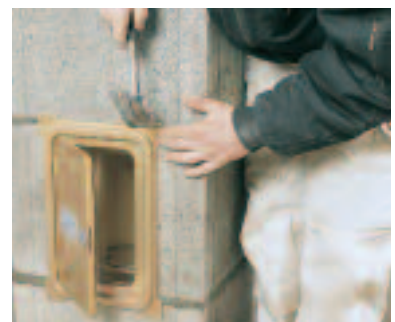
Fest sotluken til elementet med vedlagte spesialstifter. Innvendig ramme skyves mot sotluckerøret.
