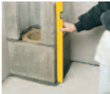
Monter neste element og sørg for at dette står i lodd.
