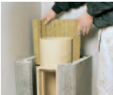
Sett i en isolasjonsplate i bakkant av sotluckerøret.
