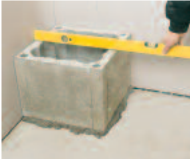
Fest første element til fundamentet med mørtel eller fugekitt. Vatre opp.
