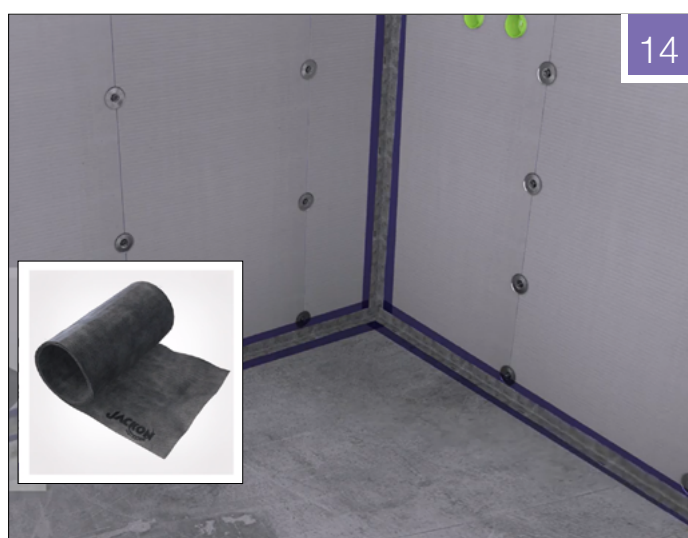
Fig. 14: Påfør membran i 10 cm bredde på vegg og gulv. Påse at det smøres godt med membran slik at sikkerhetsremsen hefter seg til membranen. Fjern eventuelle luftlommer bak remsen.
