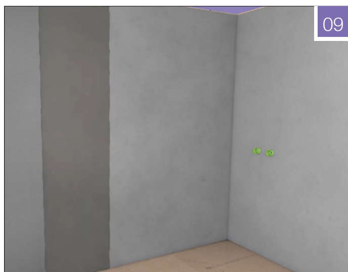
Fig. 09: Både Jackoboard Våtromsplate kan monteres direkte på mur- eller betongvegg.
