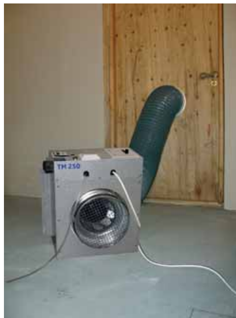
Montering i byggedør
