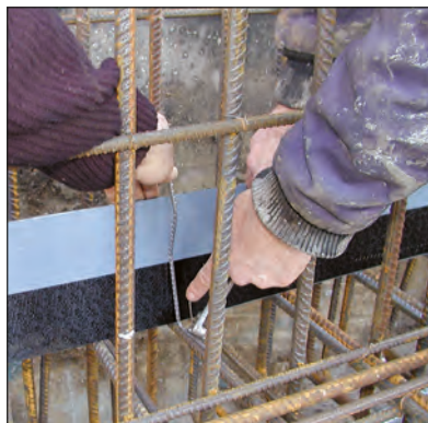
Montering med monteringsklemme på armeringen.
