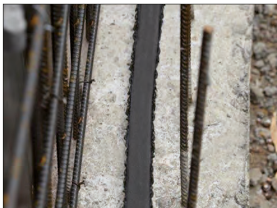
Montering med svellebåndslim
