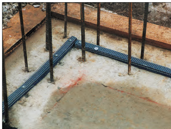
Montering med festegitter og spiker
