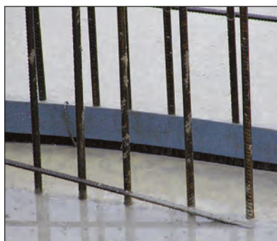
Sikker innfuging i betongen, maksimalt halv platebredde.
