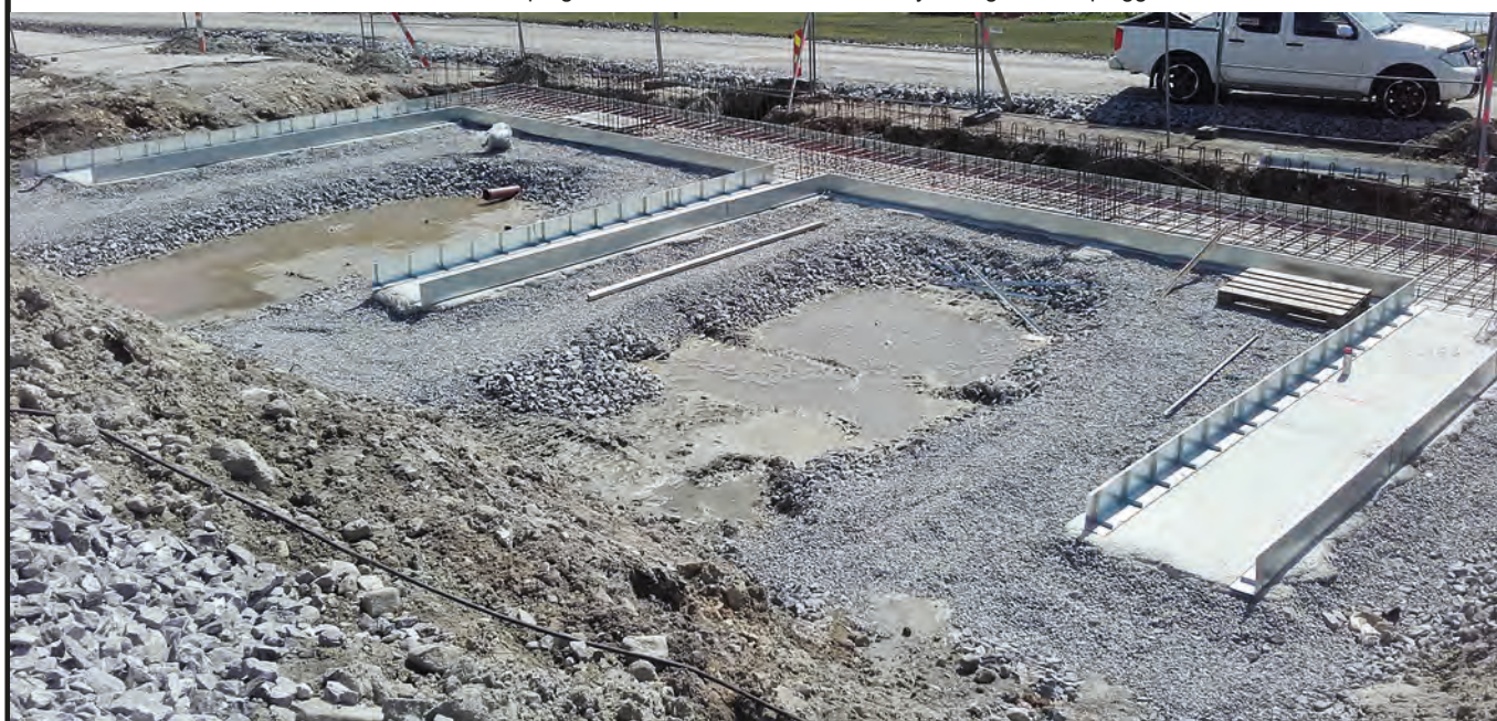
2. Sikre kantforskaling fra å flytte seg med en plugg.
