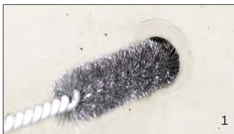
Rengjør avstandsstykket hvis det er tilsmusset
