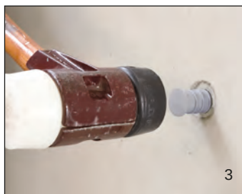
Slå inn STOPPER med gummihammer
