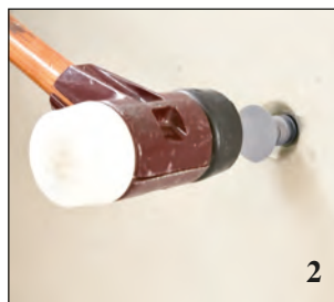
Slå inn med gummihammeren
