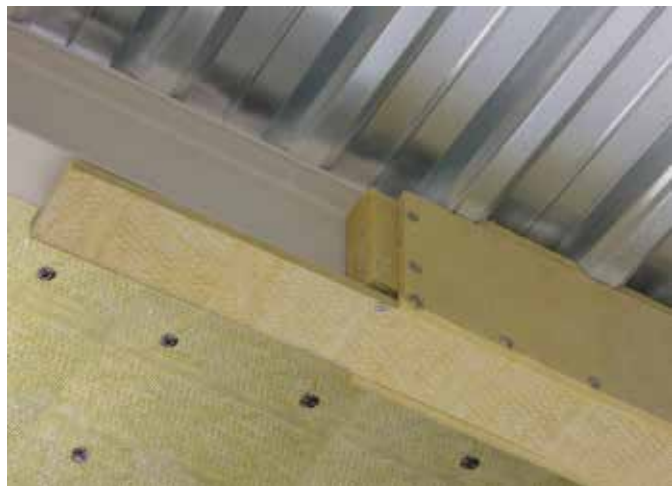
Fire siders brannbeskyttelse av en stålbjelke. Bruk Isover FireProtect 150 plater for å fylle ut de trapesformede profilene på toppen av bjelken.
